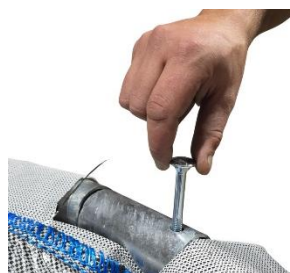
Slika 10: vstavite in privijte vijaka nosilnega obroča
