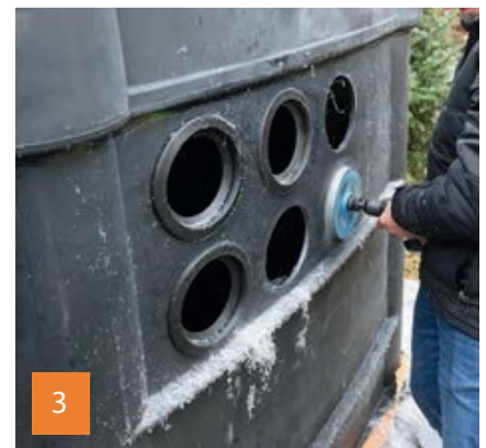
3 Einbau der Schachtanschlüsse.
