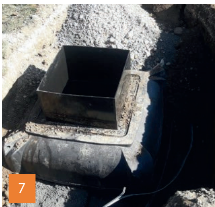
7 Demonstration des Erdungsvorgangs im Schacht.
