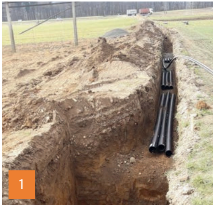
1 Vorbereitung der Baugrube.
